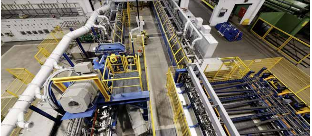
Neue XTP-Anlage bei Steeltec in Düsseldorf, Deutschland
